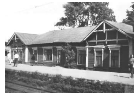
Стация Болшево (Подмосковье). МЦ жила 145 дней в посёлке «Здоровый быт», а Ахматова лечилась в реабилитационном санатории. Фото А. Балакина.
